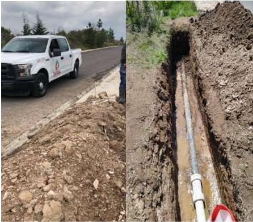
Imagen 49. Reparando fuga de agua
